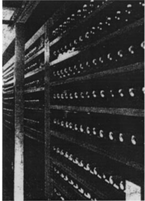
Orgue Givelet et Coupleux : circuits d'oscillateurs.
